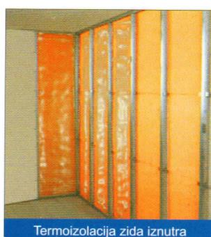
Termoizolacija zida iznutra
