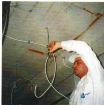
Na betonskoj tavanici visilice se fiksiraju pomoću šrafa sa metalnim tiplom.
