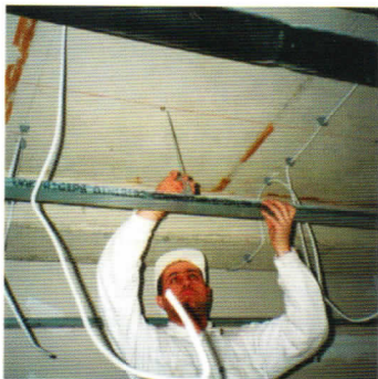
Prvi red CD-profila kači se na vešaljku i podešava na odgovarajuću visinu.
